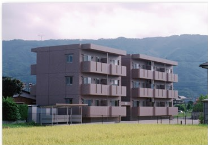
グランコート箕輪 2006年4月竣工
