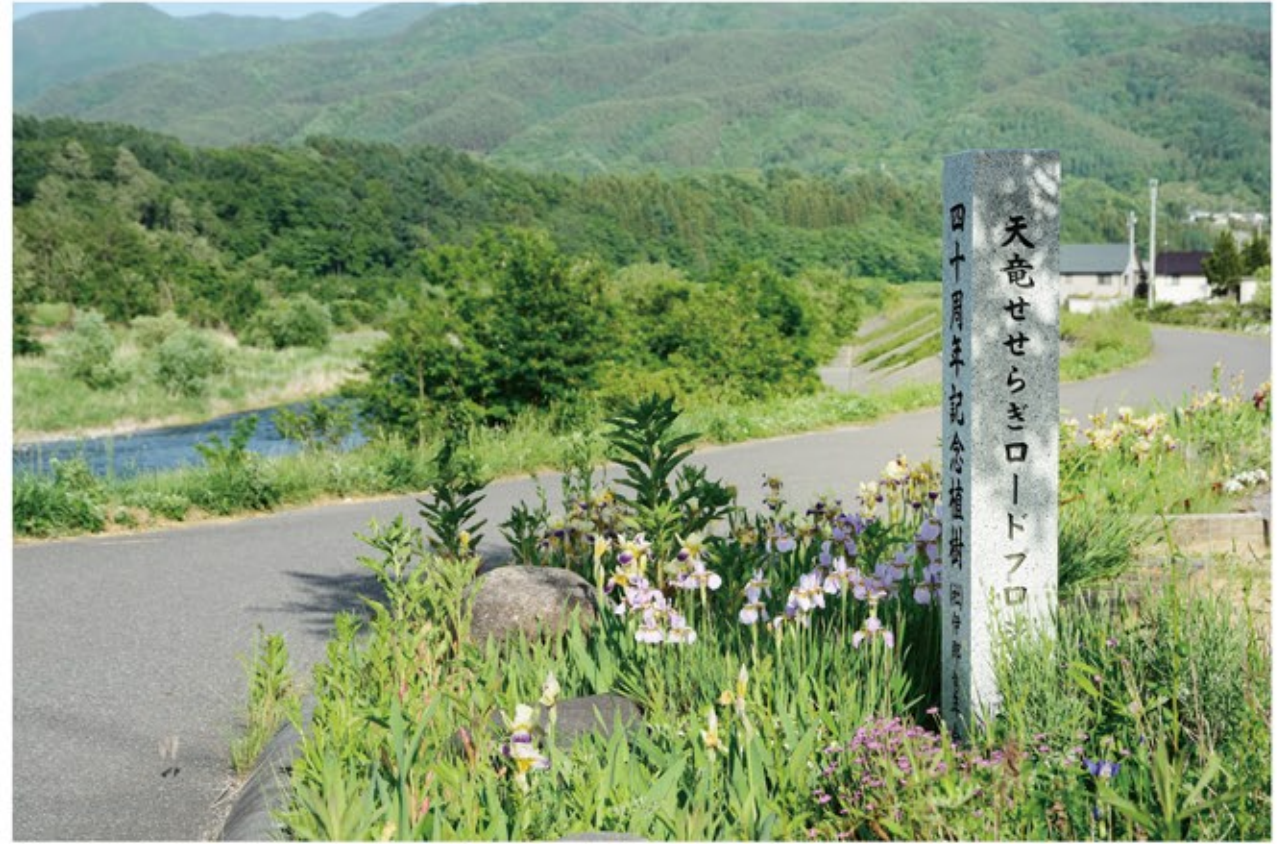
「天竜せせらぎロードプロジェクト」により、箕輪町天竜川沿いにある護岸の利活用のため舗装された川沿いの道(2018年5月25日)
